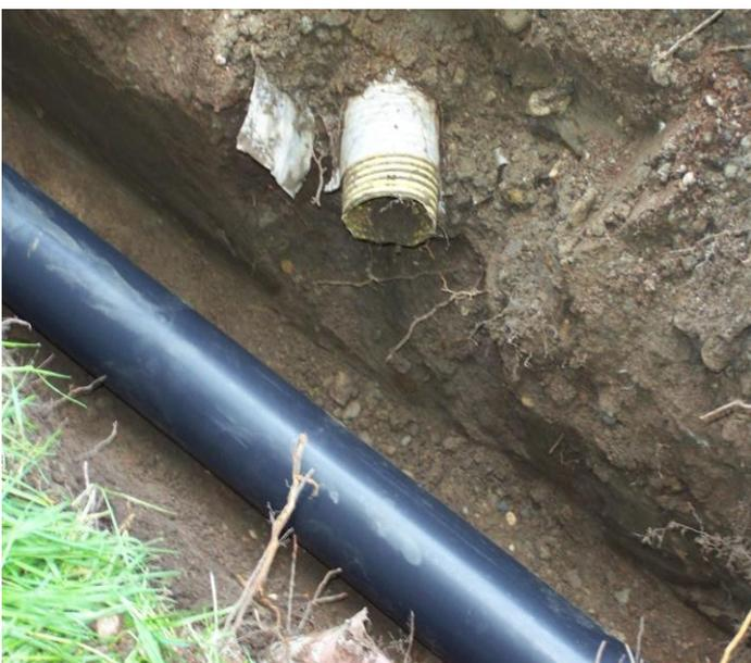
Bei Verlegungsarbeiten eines Elektrokabels gelang es der Baufirma 10 Entwässerungsleitungen an der Bachseite durchzutrennen
